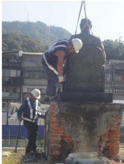
05銅像與現有基座接合面打除作業
