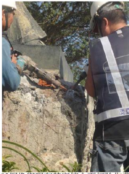
02銅像與現有基座接合面打除作業
