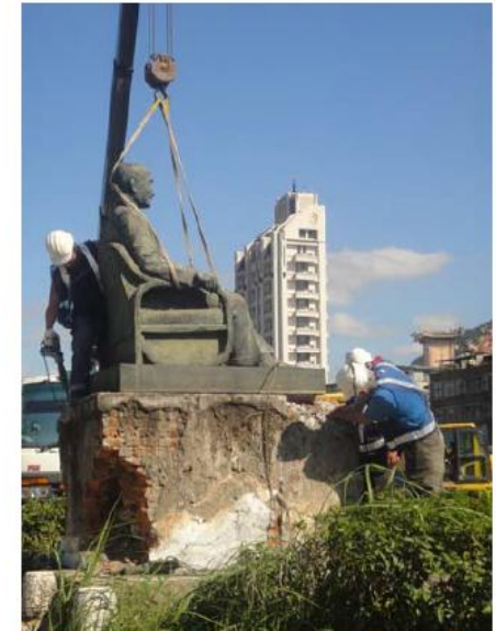
06銅像與現有基座接合面打除作業
