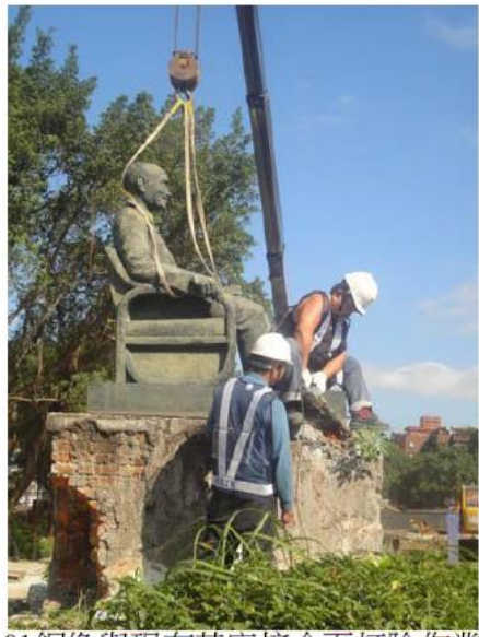
01銅像與現有基座接合面打除作業
